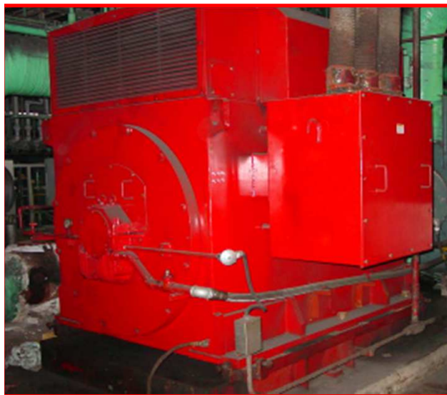
■ 台電核能發電廠 台灣 冷卻水幫浦 2,250HP; 276RPM
