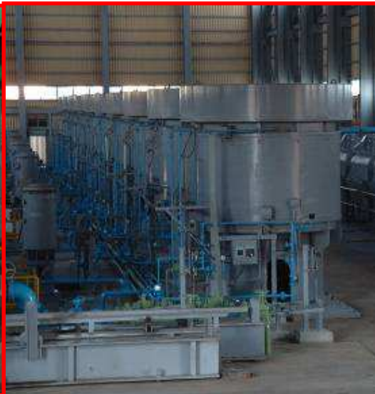
■ 林口電廠 台灣 鍋爐給水幫浦 ODP 2P; 7,000HP
